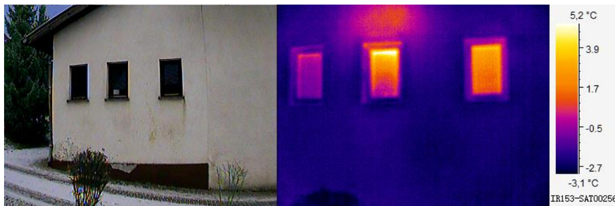
Slika 42: Termografija severovzhodnega dela stavbe
