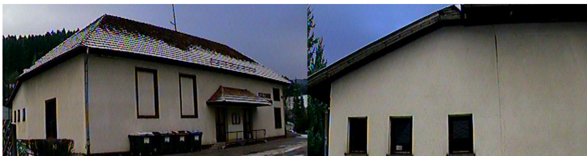
Slika 16: Zunanji ovoj stavbe
