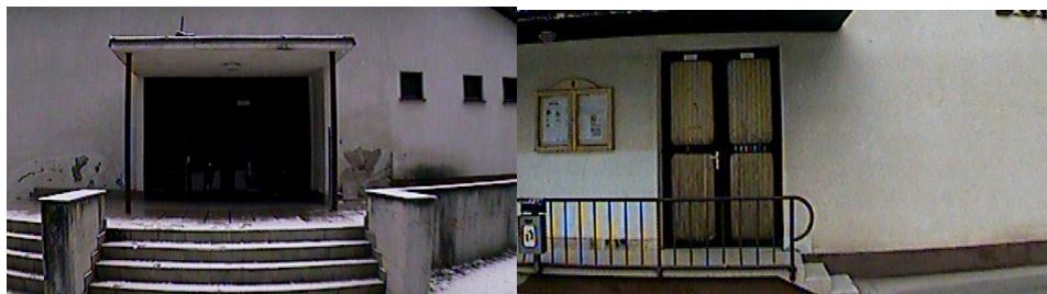
Slika 18: Energetsko neučinkovita vrata
