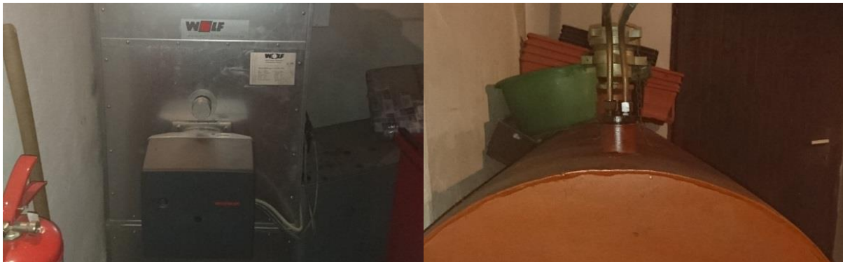
Slika 9: Postavitev kotla v kurilnici in rezervoar za kurilno olje
